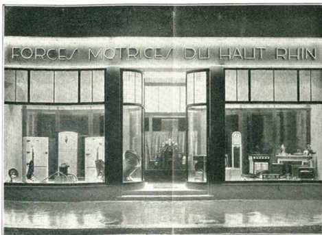
FIG. 1 — Vue extérieure du Magasin. On remarquera la disposition particulièrement attrayante des vitrines et leur éclairage très réussi.
