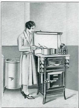
Fig. 5. — La cuisinière électrique et à gauche la lessiveuse électrique.
