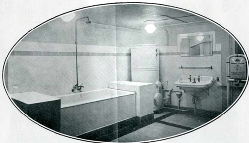
FIG. 3. — La salle de bains équipée avec un chauffe-eau à accumulation dont on distingue les détails de la tuyauterie, intentionnellement mise en évidence.
