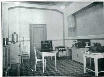
FIG. 4. — La cuisine où sont exposés les appareils électriques, four, chauffe-eau, cuisinière, Electro-économe, armoire frigorifique, etc...
